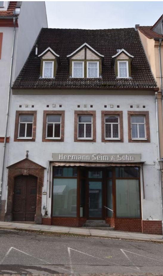
Abbildung 40: Lutherplatz 6 mit Ladeneinbau von 1908 (erneuert)
