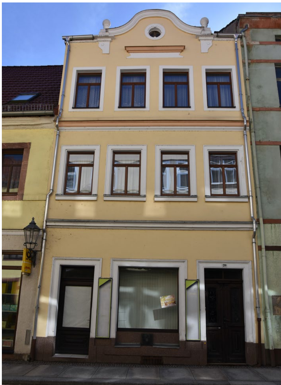
Abbildung 26: Straßenseitige Ansicht mit Ladeneinbau und ausgebautem Dachgeschoss
