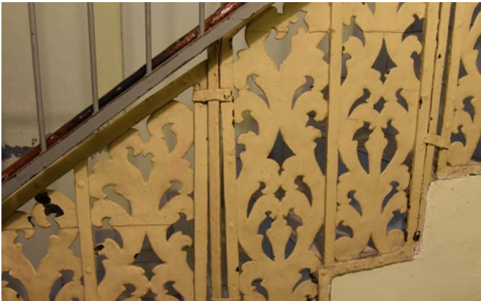
Abbildung 46: Barockes Treppengeländer aus Metall
