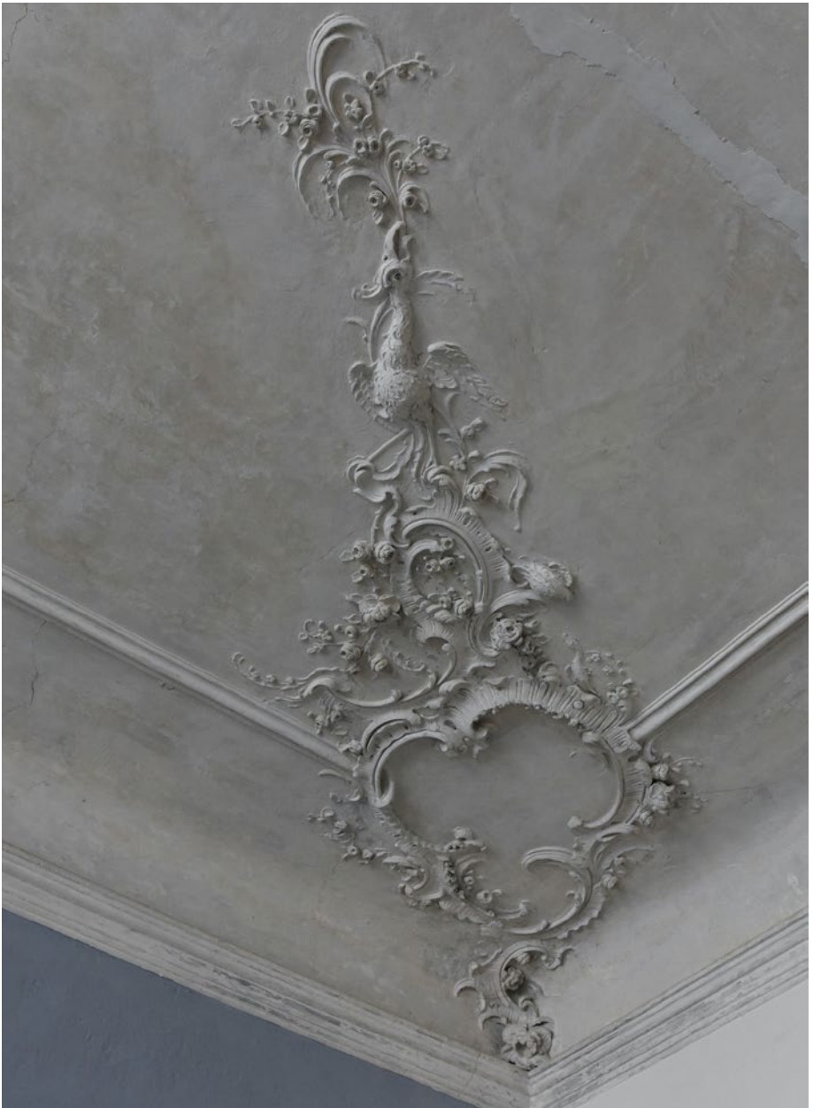
Abbildung 38: Detail der Rokoko-Stuckdecke
