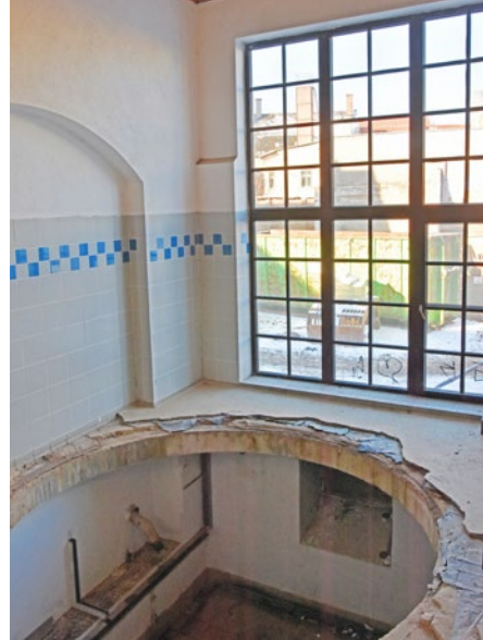
Abbildung 17: Heutige Situation nach Ausbau der 1992 eingebauten Kupferkessel
