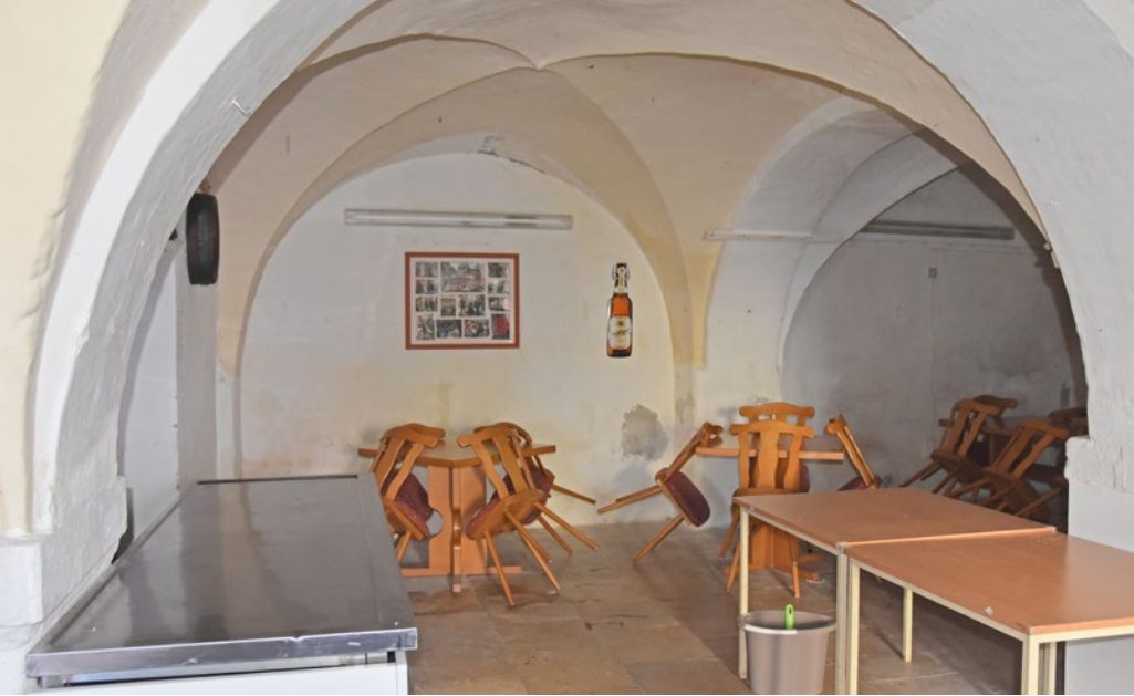
Abbildung 4: Kreuzgratgewölbe des ehemaligen unteren Malzbodens
