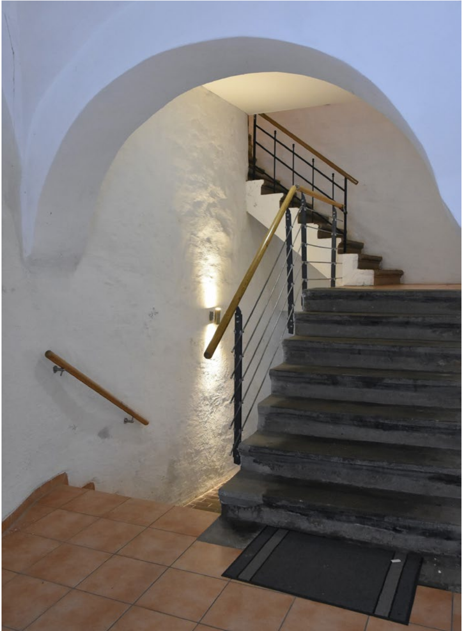
Abbildung 57: Blick in das Treppenhaus
