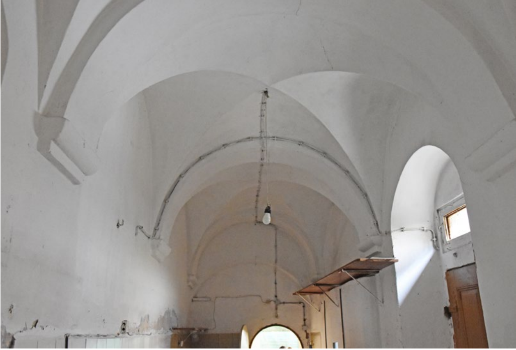
Abbildung 43: Kreuzgratgewölbe im Nebengebäude
