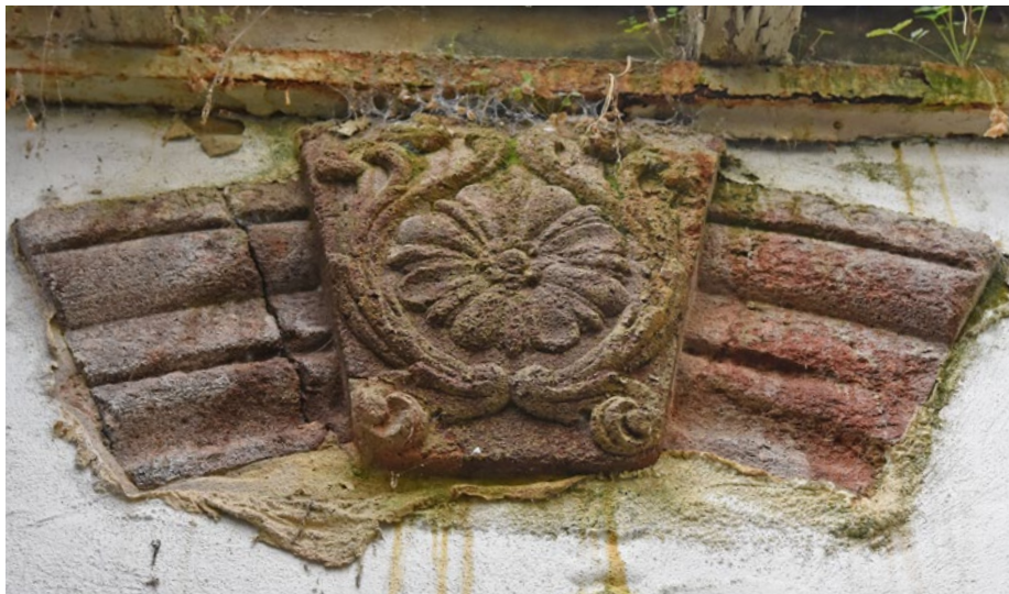
Abbildung 2: Spolie mit Blütenmotiv, möglicherweise von einer Vorgängerbebauung stammend
