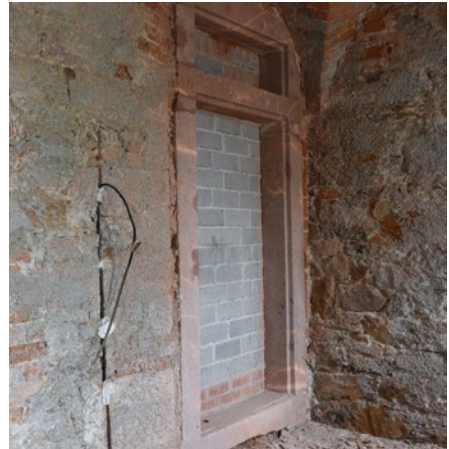
Abbildung 34 und 35: Vielfach überwölbtes Treppenhaus und Porphyportal mit Oberlicht
