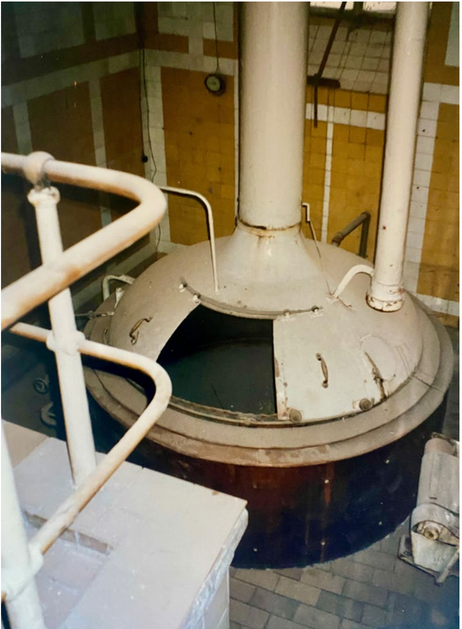
Abbildung 16: Aufnahme des ehemaligen Sudkessels im Jahr 1992, Quelle: Denkmalakte UDB
