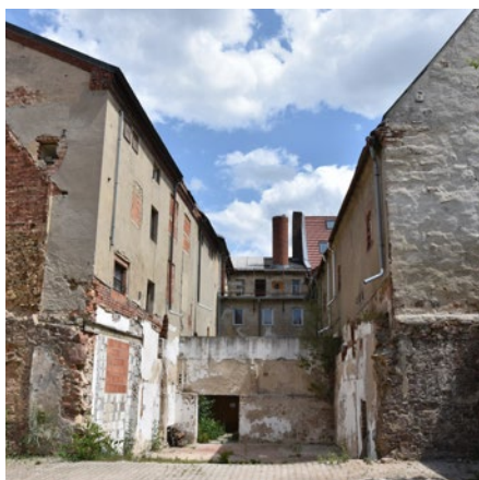
Abbildung 18: Innenhof der Brauerei mit dazugehörigem Hintergebäude Lutherplatz 4
