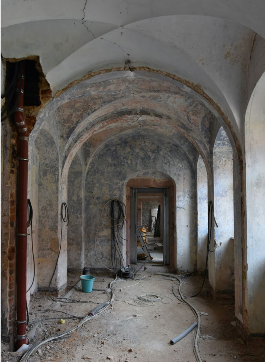
Abbildung 37: Blick in das Obergeschoss des südlichen Nebengebäudes
