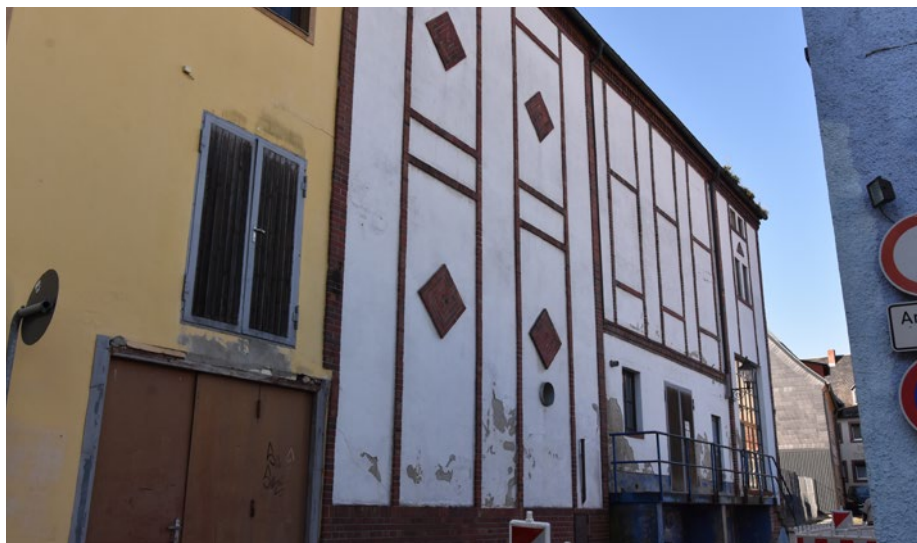
Abbildung 13: Kellereigebäude und Sudhaus, heutige Situation
