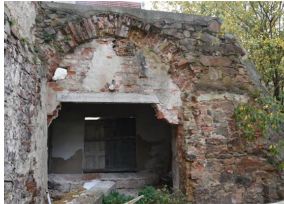
Abbildung 22: Mauerreste ehemals angrenzender Bauten sind zur Absicherung der Fassade erhalten worden.
