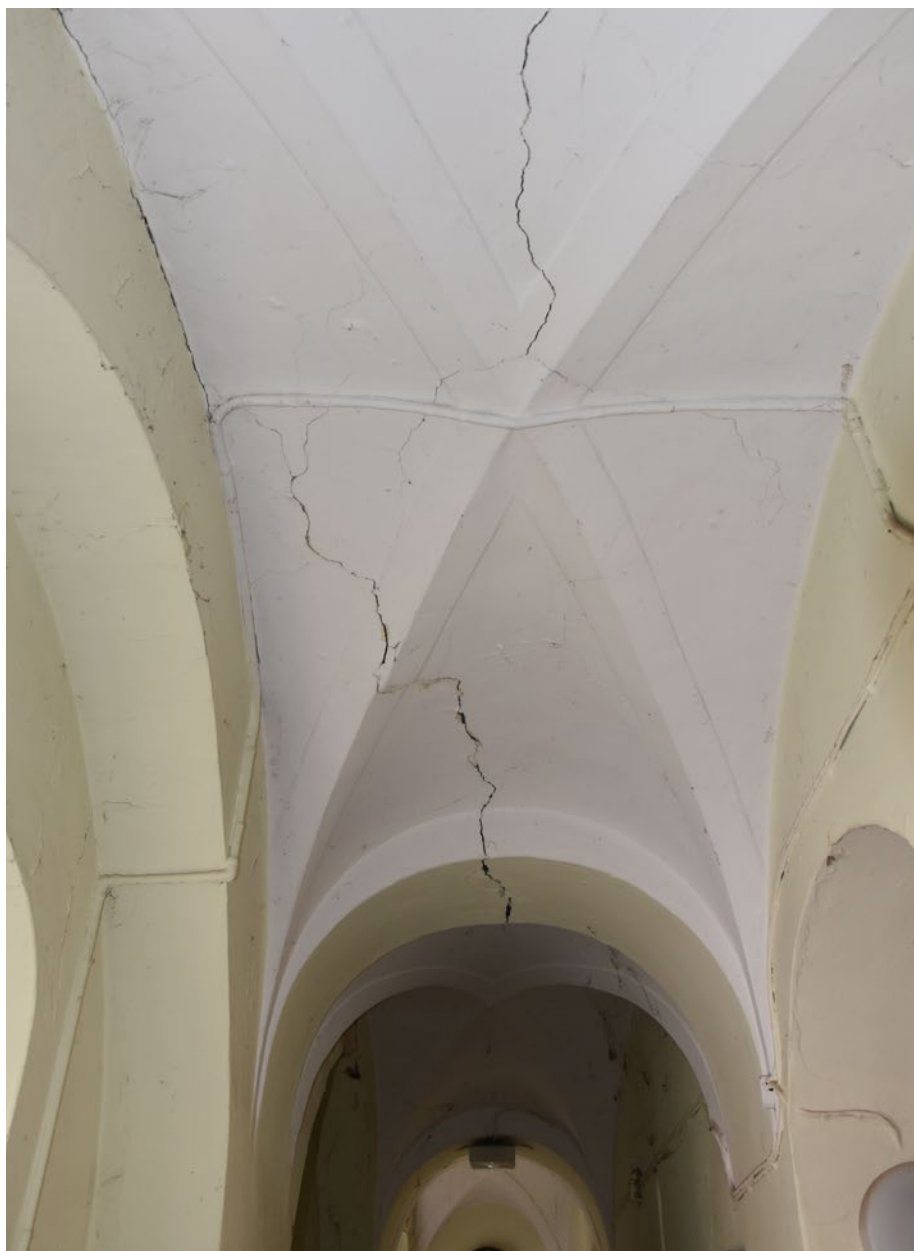
Abbildung 23: Kreuzgratgewölbe im schmalen Flur auf der Nordseite
