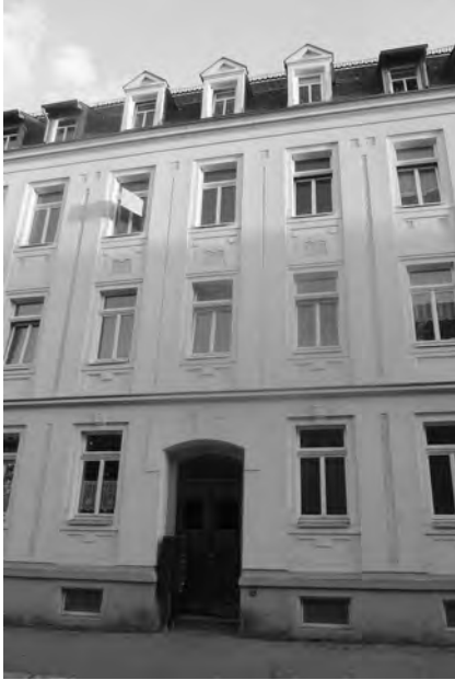
Fassadenseitige Aufnahme des Gebäudes Sachsenstraße 9
