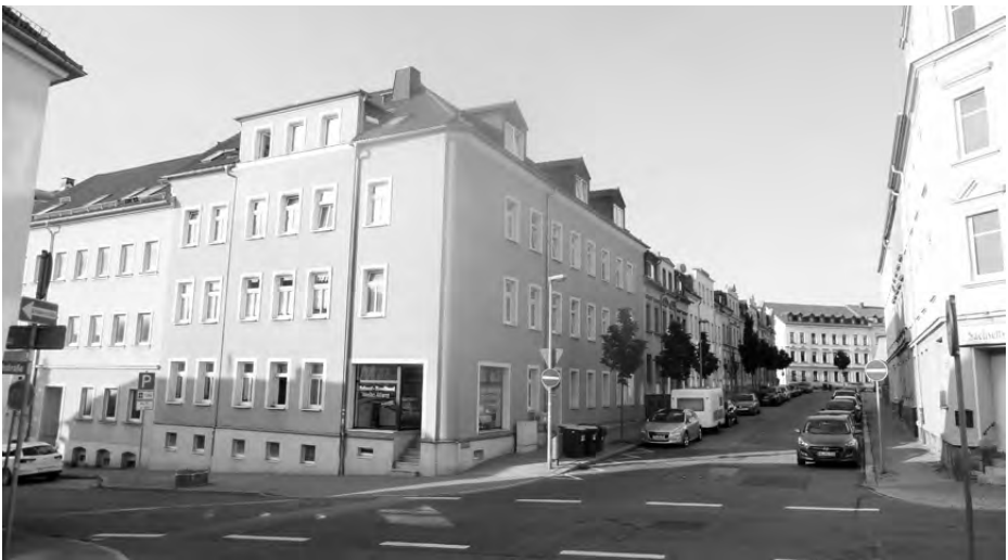
Altenhainer Straße / Sachsenstraße. Von dieser Ecksituation aus wuchs ab 1879 die Bebauung entlang des Straßenzuges.
