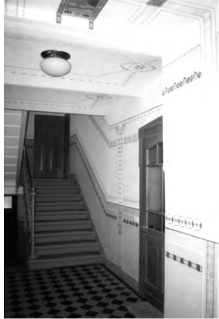
Eingangsbereich/Treppenhausflur des Gebäudes Sachsenstraße 9
