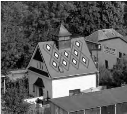
Nach abgeschlossener Rekonstruktion präsentiert sich das zum Wohnhaus umgenutzte Wasserhaus mit farbigem Dachbelag und hellem Putz (Privatbesitz Andreas Teuchner)
